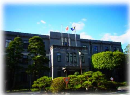
旧熊本高等工業学校本館
