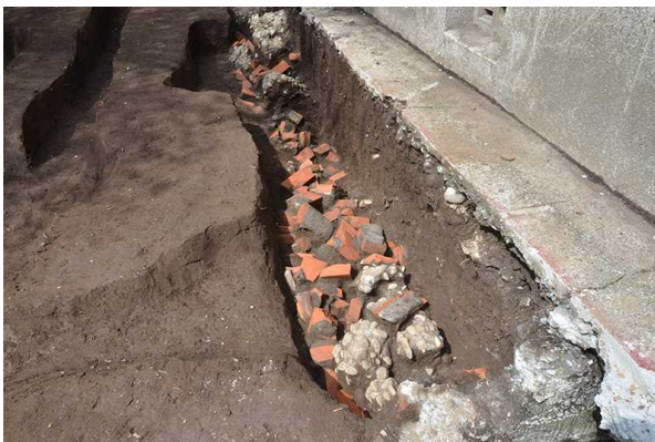
写真 3 : 破壊を受けた赤煉瓦基礎
